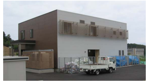
写真1 エコセンター
