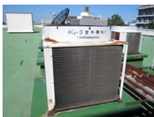
（改修前）室外機
